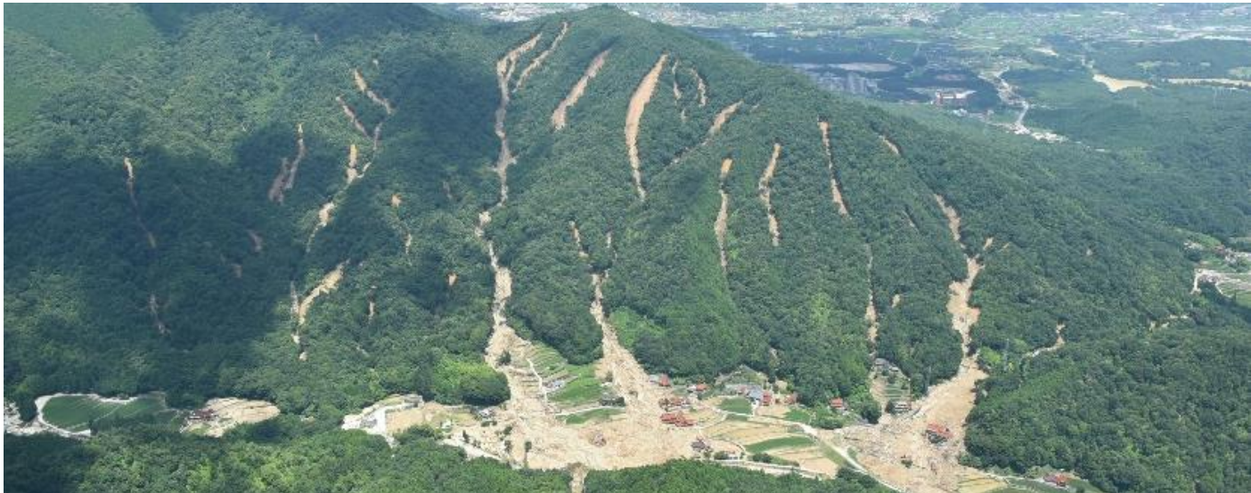
[2018年広島豪雨での土砂流出の例]
